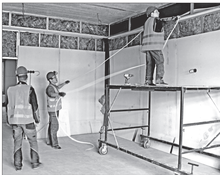
📷 Работает бригада электромонтажников
